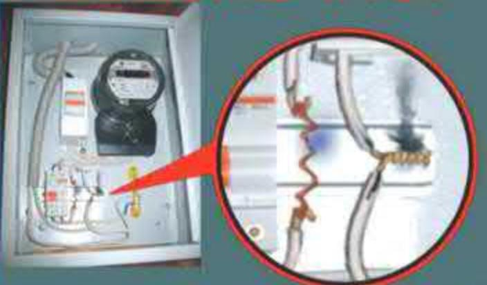
Плавкі вставки запобіжників повинні бути калібровані із зазначенням на клеймі номінального струму вставки. Застосування саморобних некаліброваних плавких вставок заборонено
